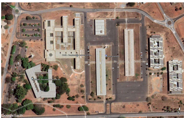
Figura 16. Estacionamentos: FD, FACE, PAT, PJC, CIC/EST e Amarelinho Norte. Fonte: Google Earth, outubro de 2022.
